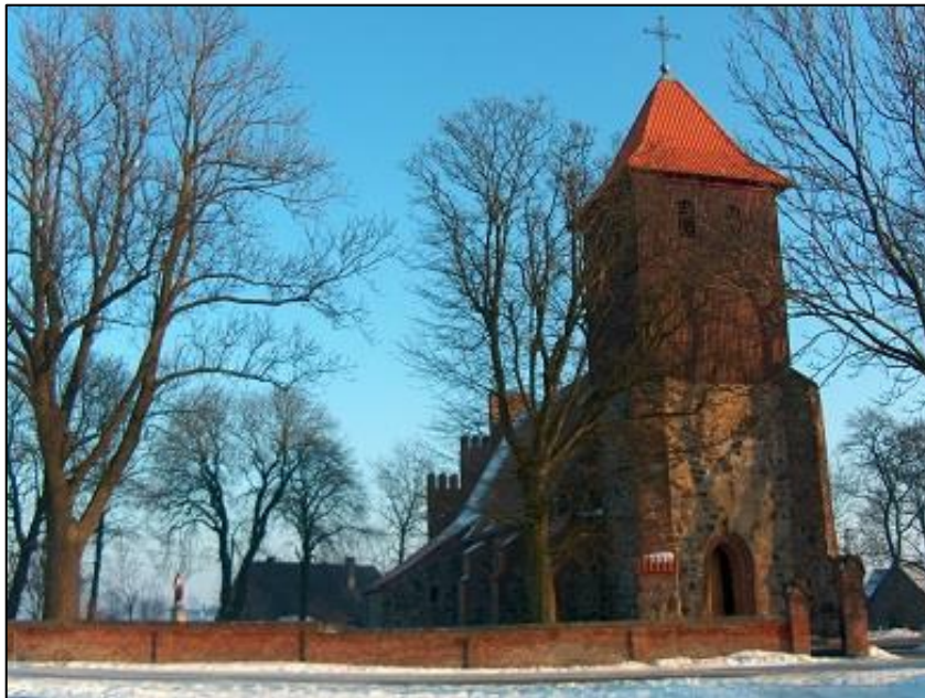
Kościół pw. św. Michała Archanioła w Grzybnie
