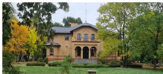
Fotografia 11. Widok na Dwór w Orłowie.
