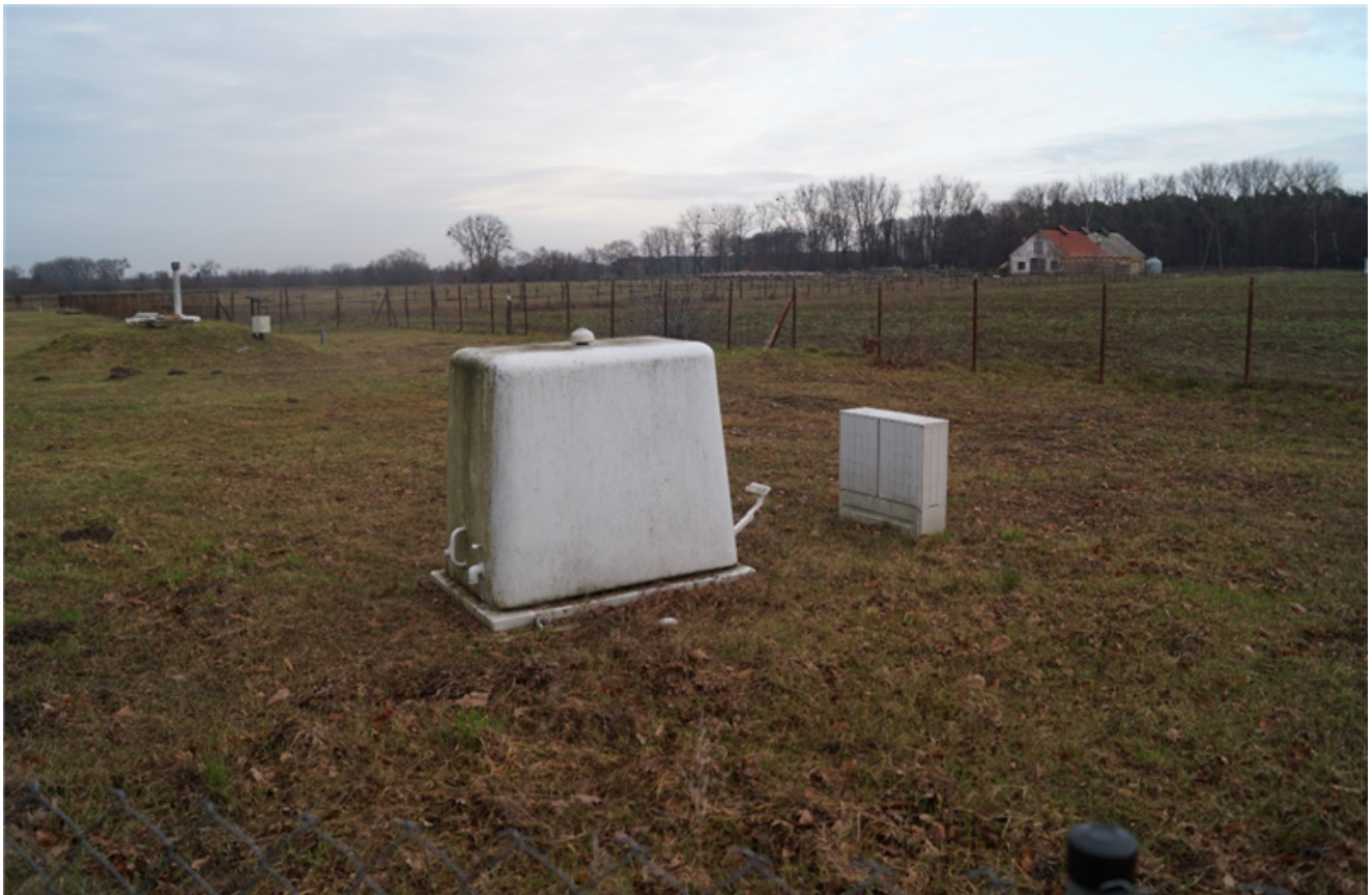
Rys. . Otwór Nr 5 Ujęcie Dębice
