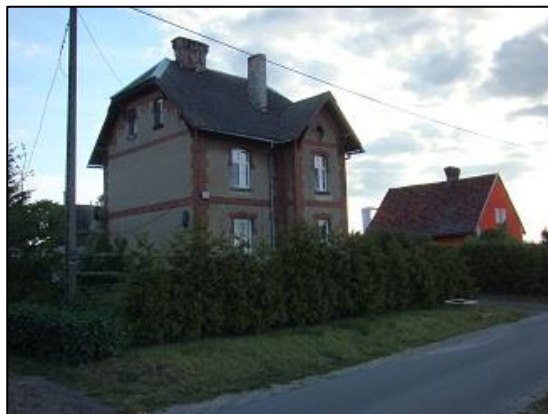
Budynek kolejowy w Firlusie
