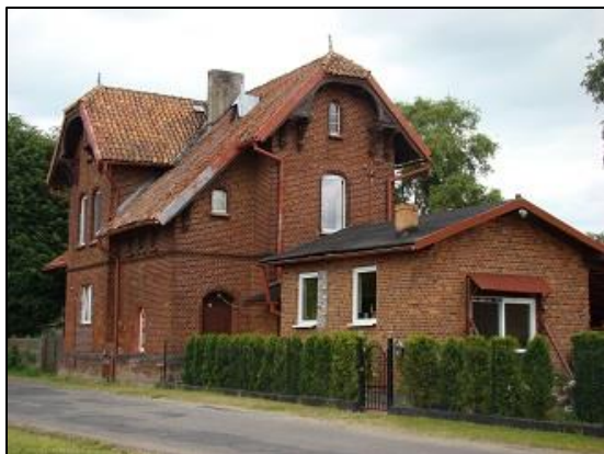
Budynek dawnej stacji kolejowej w Starogrodzie
