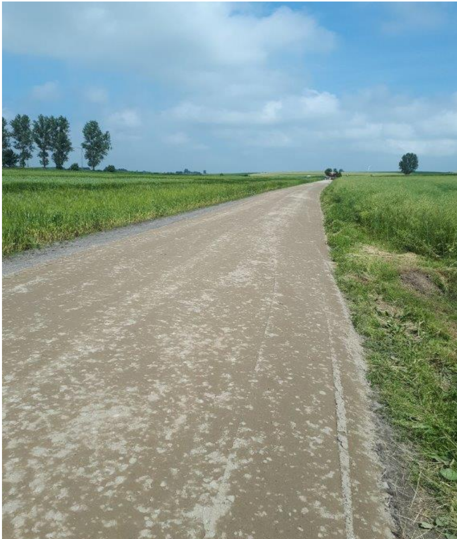
Budowa drogi w miejscowości Dulsk-Spiczyny
