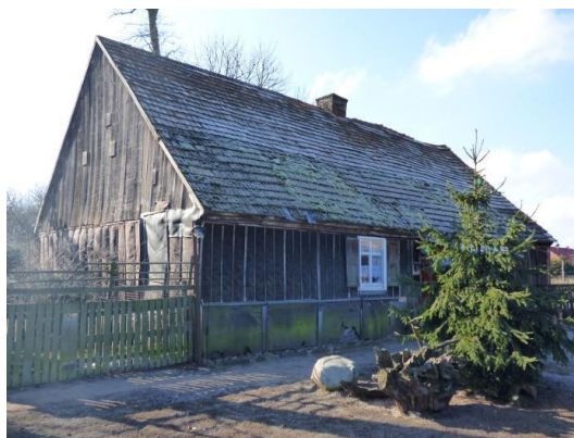
Fot. 5. Przykład budownictwa drewnianego na terenie Gminy Szubin
