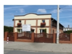
126-Koronowo, Dworcowa nr 49, magazyn, ob. dom
