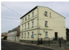
235-Koronowo, Paderewskiego nr 19, dom
