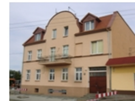
237-Koronowo, Paderewskiego nr 25, dom
