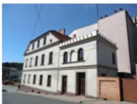
241-Koronowo, Sawickiej nr 1, dom
