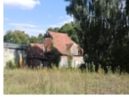
77-Koronowo, Bydgoska nr 21 magazyn pomocniczy
