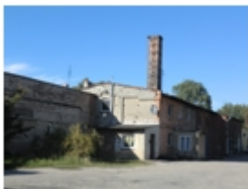
187-Koronowo, Kotomierska ceglarnia ob. bud. mieszk.
