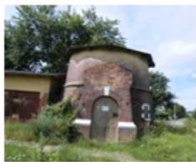
136-Koronowo, Dworcowa wieża ciśnień
