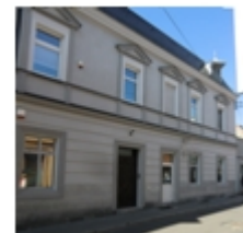
258-Koronowo, Sobieskiego nr 1, dom
