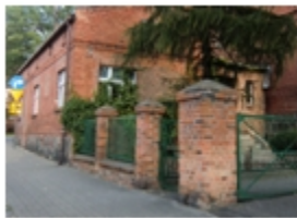
271-Koronowo, Szkolna nr 4, ogrodzenie szkoły
