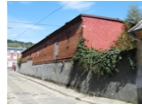
210-Koronowo, Nakielska nr 1, magazyn
