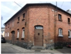
250-Koronowo, Sienkiewicza 4-6 róg Podwórzowej, magazyn
