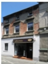
259-Koronowo, Sobieskiego nr 2, dom
