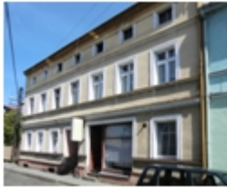
262-Koronowo, Sobieskiego` nr 12, dom
