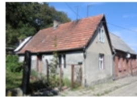
192-Koronowo, Krasickiego nr 22, dom
