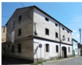
199-Koronowo, Łokietka nr 6, magazyn
