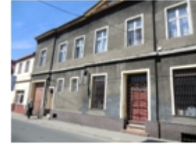
267-Koronowo, Staromiejska nr 2, dom
