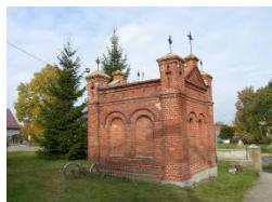
364-Mąkowarsko, kaplica grobova przy kościele
