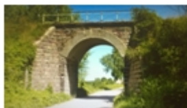
20-Buszkowo, wiadukt kolejowy
