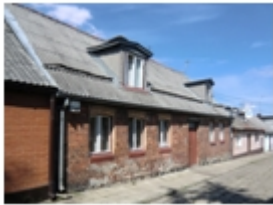
190-Koronowo, Krasickiego nr 14, dom
