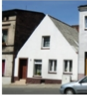
4-Koronowo, Garncarska Nr 5, dom
