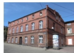
189-Koronowo, Krasickiego nr 2, dom
