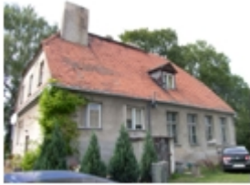
40-Glinki nr 17, szkoła ob. budynek mieszkalny
