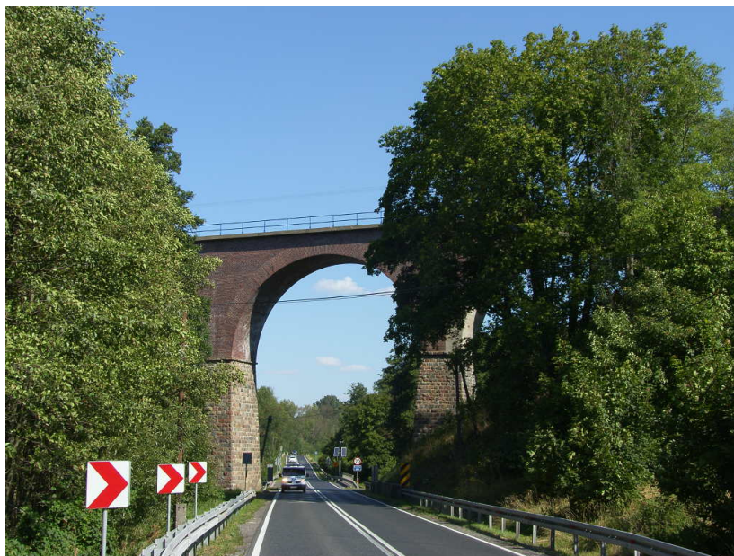
Most kolejowy nad rzeka Kamionką, 1909 r., nr rej. A/421 z dnia 17.07.1997 r.
