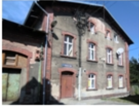
208-Koronowo, Łokietka nr 31, elektrownia
