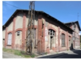
209-Koronowo, Łokietka nr 31, magazyn
