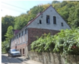
193-Koronowo, Krasickiego nr 26, dom
