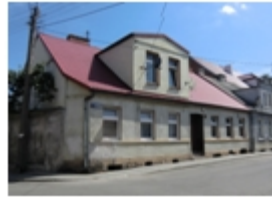
266-Koronowo, Sobieskiego nr 20, dom
