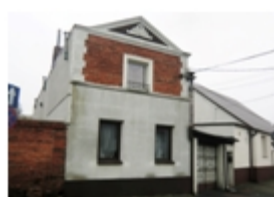
146-Koronowo, Farna nr 27 magazyn, ob. dom
