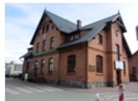
239-Koronowo, Pomianowskiego nr 3 B, budynek admin.
