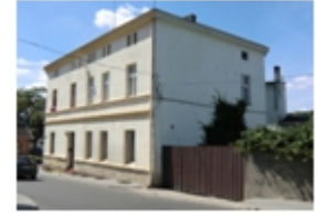
156-Koronowo, Garncarska nr 9, dom
