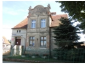
230-Koronowo, Paderewskiego nr 1, dom
