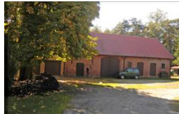
500-Wilcze Gardło - budynek gospod.
