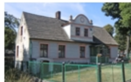
236-Koronowo, Paderewskiego nr 20, dom
