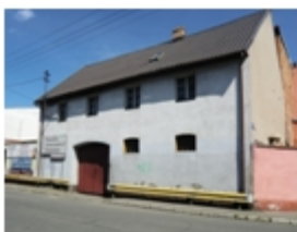
202-Koronowo, Łokietka nr 12, magazyn
