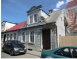
265-Koronowo, Sobieskiego nr 18, dom
