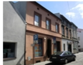
260-Koronowo, Sobieskiego nr 4, dom
