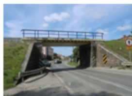
188-Koronowo, Kotomierska wiadukt kolejowy
