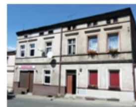
153-Koronowo, Garncarska nr 3, dom
