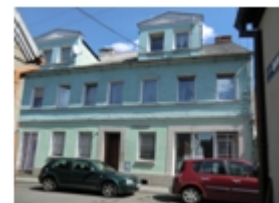
261-Koronowo, Sobieskiego nr 10, dom
