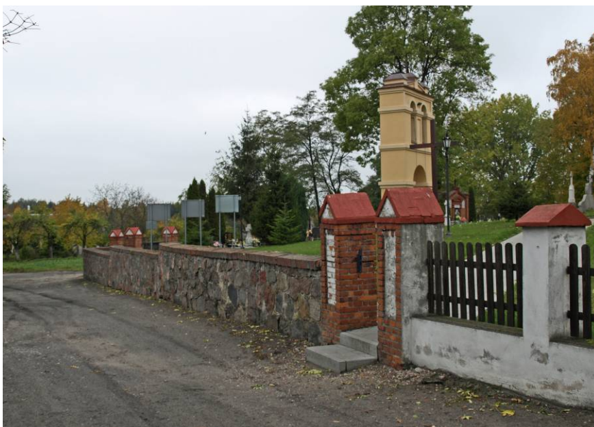
Ogrodzenie cmentarza, 2 poł. XIX w., nr. rej. j.w.
