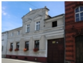
232-Koronowo, Paderewskiego nr 7, dom
