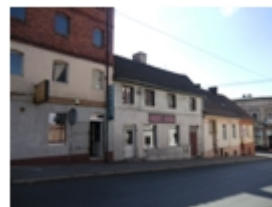
242-Koronowo, Sawickiej nr 2, dom
