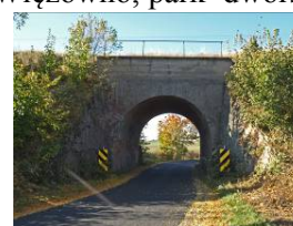
486-Wilcza Góra - wiadukt kolejowy
