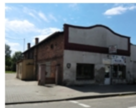
99-Koronowo, Dworcowa nr 4, magazyn ob. dom
