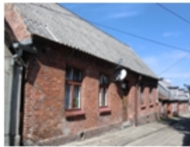
191-Koronowo, Krasickiego nr 20, dom
