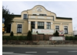
233-Koronowo, Paderewskiego nr 11, dom
