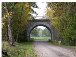
349-Lucim - wiadukt kolejowy
