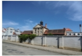
92-Koronowo, ul. Bydgoska ul. Klasztorna, mur klasztorny
