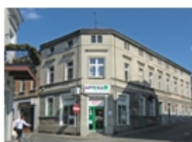
152-Koronowo, Garncarska nr 1, dom
