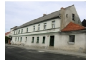
234-Koronowo, Paderewskiego nr 17, dom
