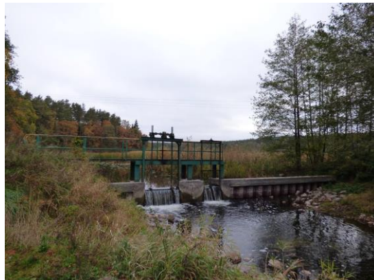
Fot. 24. Przepust wodny
