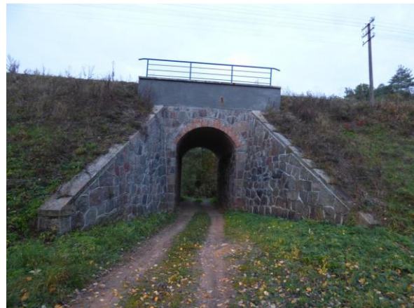
Fot. 14. Wiadukt kolejowy Źródło: zdjęcie własne
