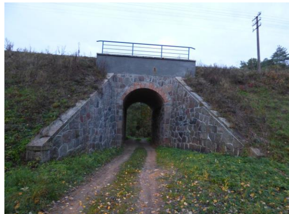
Fot. 14. Wiadukt kolejowy Źródło: zdjęcie własne
