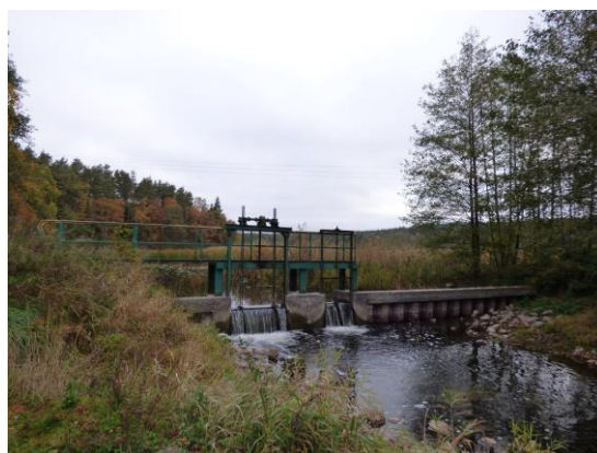
Fot. 24. Przepust wodny
