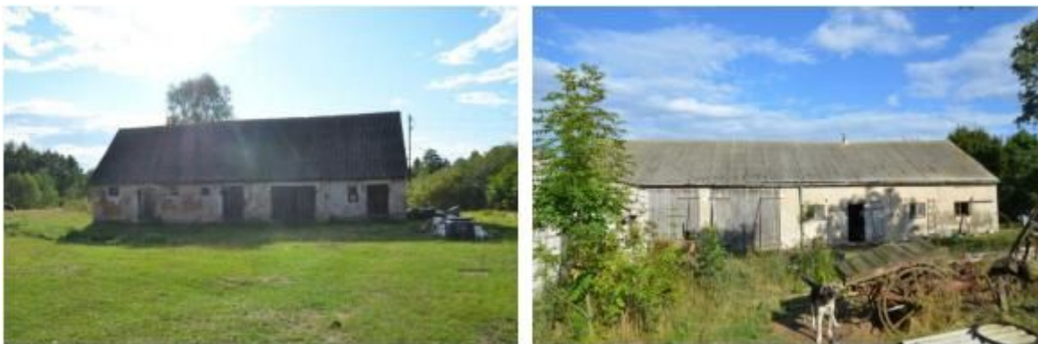
Fot. 6. Budynki gospodarcze w Szarłatach
