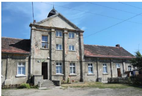
15. Koronowo - pałac opata, ob. dom mieszkalny, ul. Klasztorna nr 1
