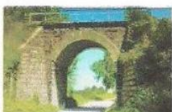
28. Buszkowo, wiadukt kol.
