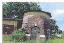
200. Dworcowa - wieża ciśniel
