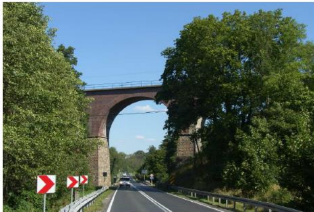
1. Buszkowo - most kolejowy nad rzeką Krówką
