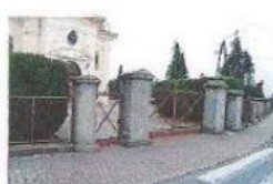
641. Wierzchucin K. mur kość.
